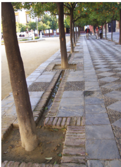
Κανάλια με όμβρια ύδατα χρησιμοποιούνται σε δεντροστοιχία νεραντζιών στην Κόρδοβα, Ισπανία
