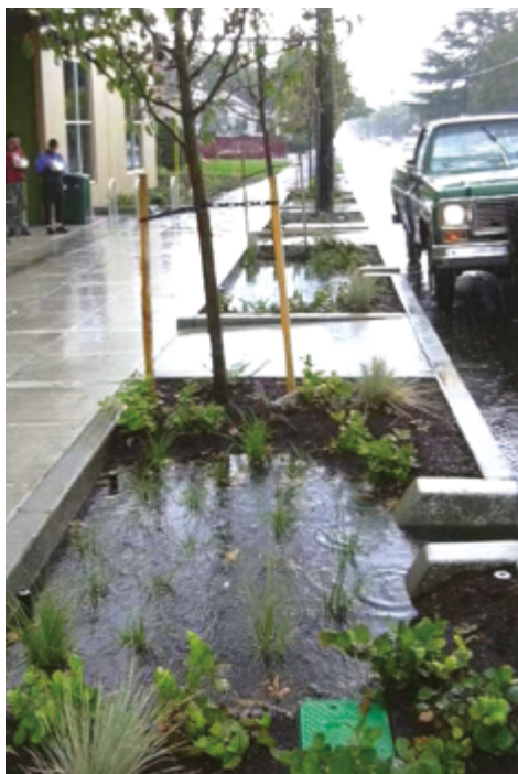
Τα όμβρια ύδατα από τα ρείθρα του δρόμου συλλέγονται σε παρτέρια-κήπους σε πεζοδρόμια στο Πόρτλαντ, ΗΠΑ
